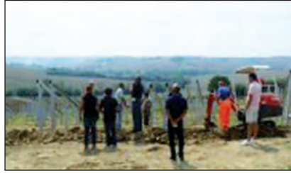
Operazione di bonifica
