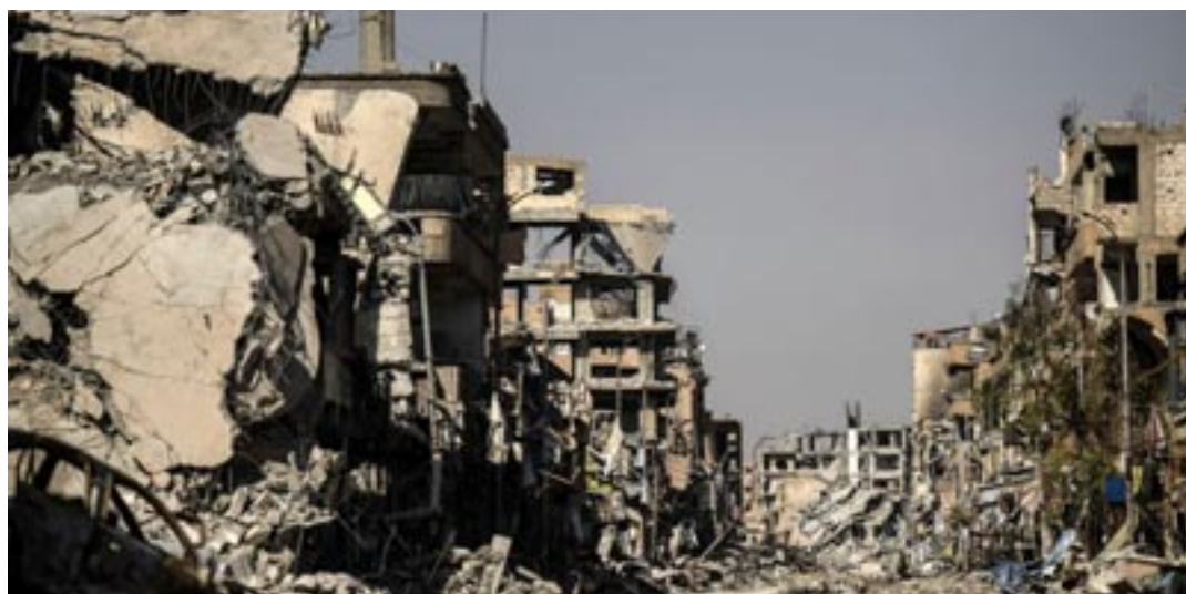
Edifici distrutti a causa dei bombardamenti
